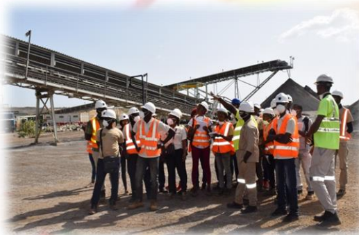
Visite de l'usine de traitement.
