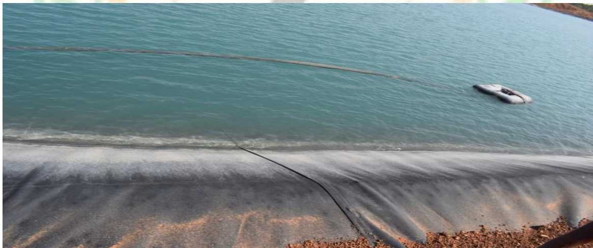
Site de traitement et de réutilisation de l'eau
