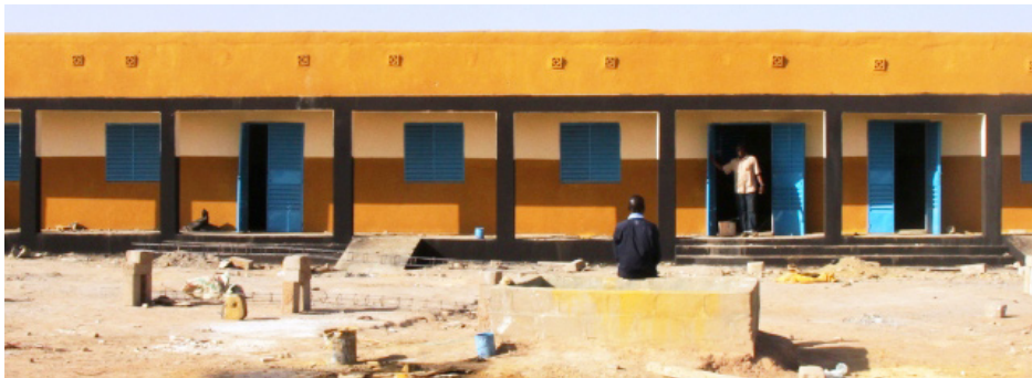
Vue d'ensemble de la nouvelle école
